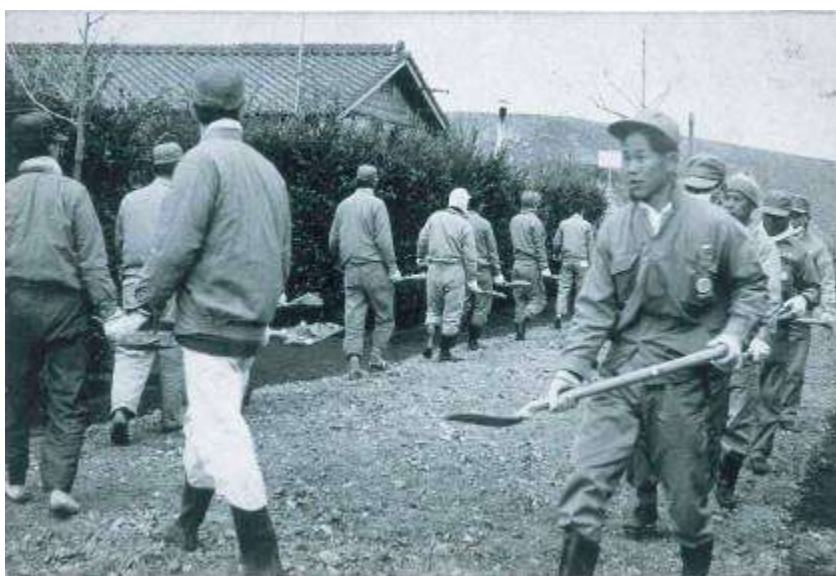
「施設五課に配属され道直し」『新日本窒素労働組合 60 年の軌跡』 p95
