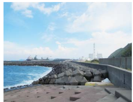
護岸とテトラポットと火力発電所
