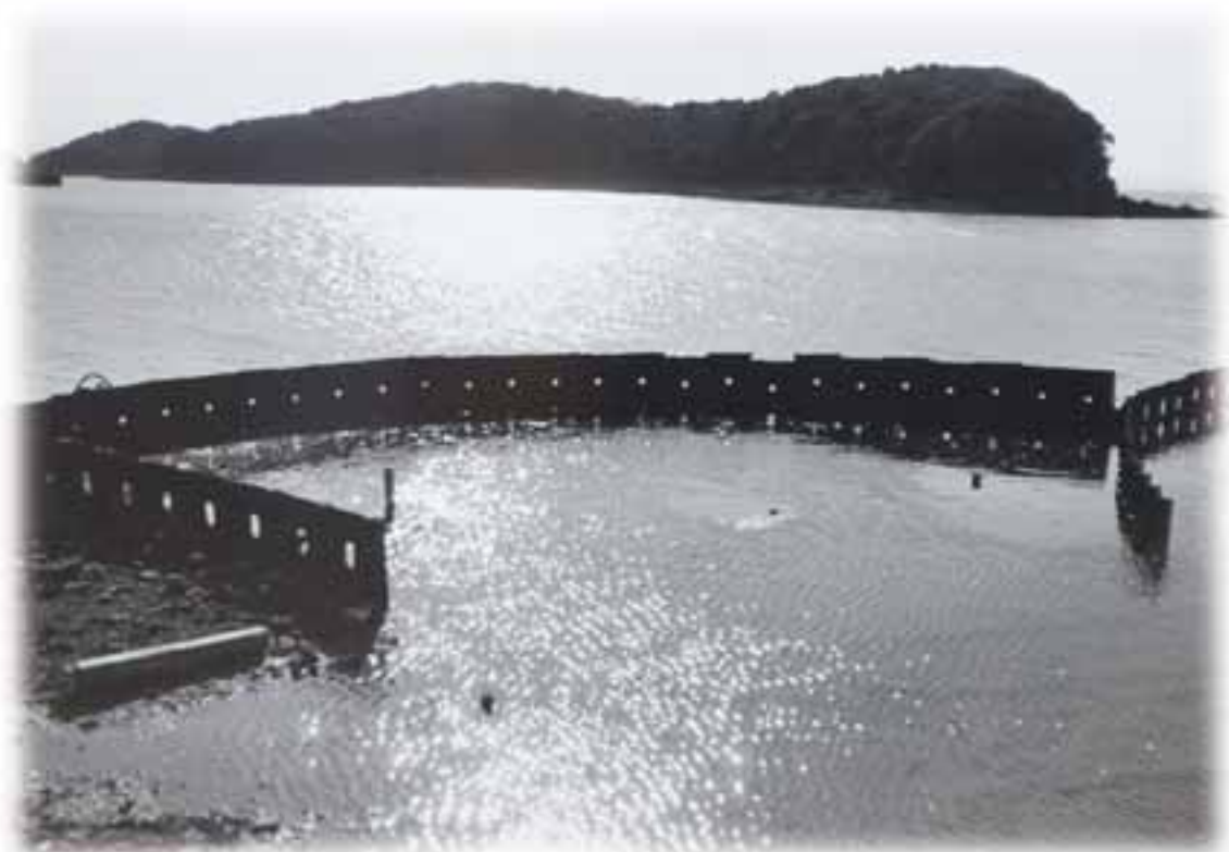
水俣湾水銀ヘドロ処理工事（写真：新日窒労組旧蔵資料）
