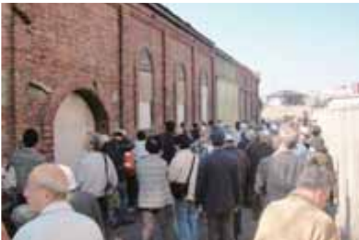
旧工場外観(写真:水俣学研究センター)
