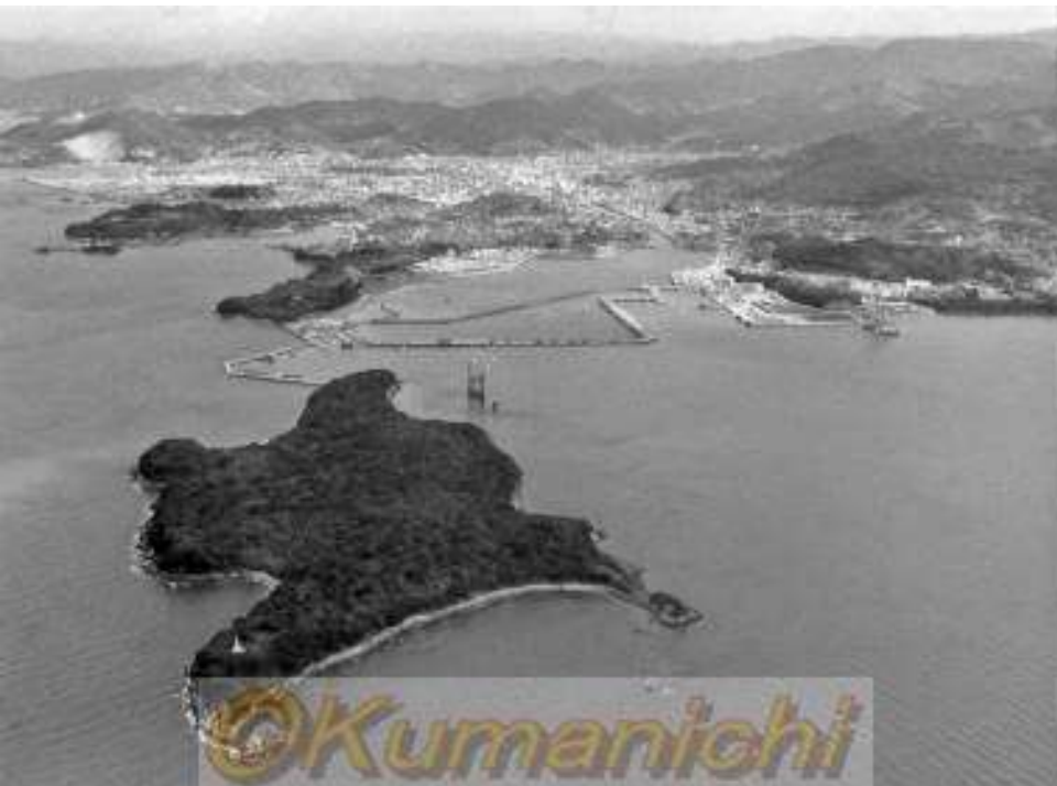
埋立て工事中
