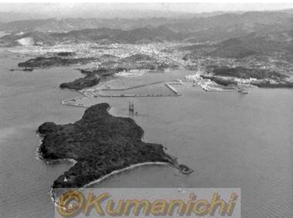
埋立て工事中
