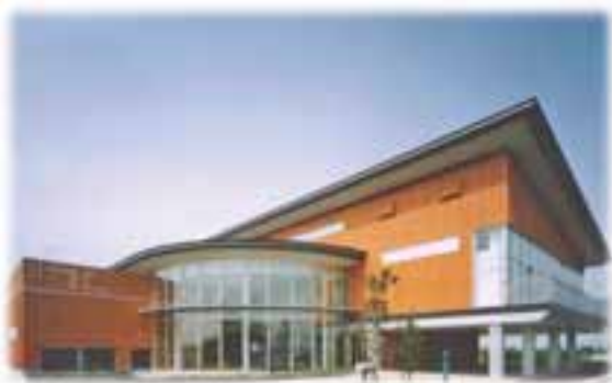
新潟県立環境と人間のふれあい館—新潟水俣病資料館— (写真：新潟水俣病資料館)
