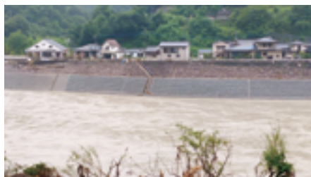
芦北町白石地区 嵩上げ工事後に浸水 (2020.7.14)
