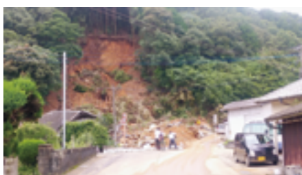
芦北町釜・小崎地区 土砂崩れ (2020.7.6)
