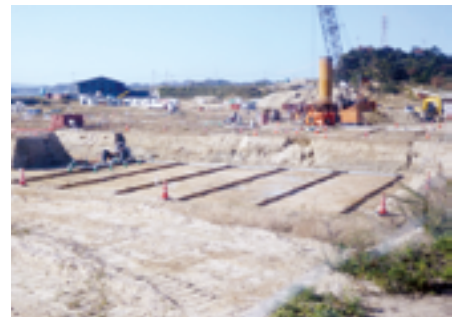
地下水浄化処理中の豊島不法投棄跡地 (写真：2020年11月筆者撮影)
