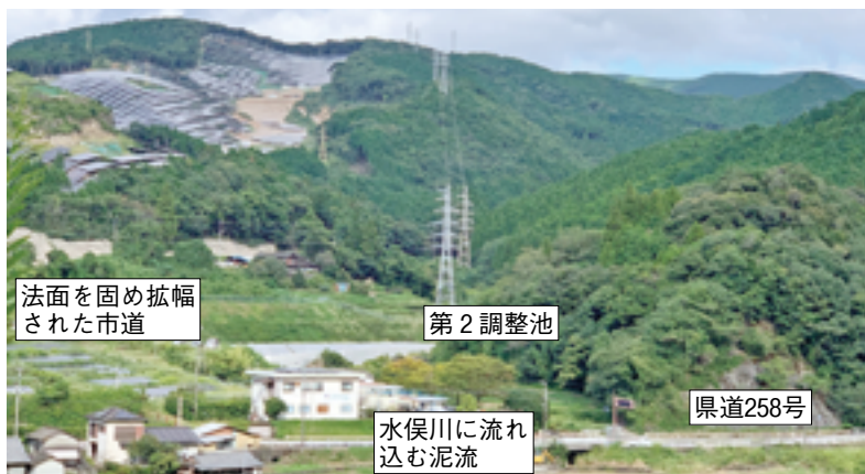
写真1 N地区に建設中のメガソーラー発電所 (2021. 9. 29 筆者撮影)
