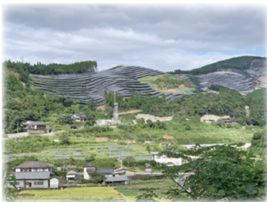
水俣市長野地区に建設中のメガソーラー (2021.9.29 宮北撮影)
