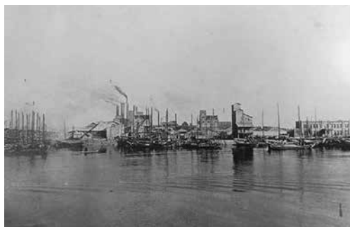
図1 日本セメント八代工場
