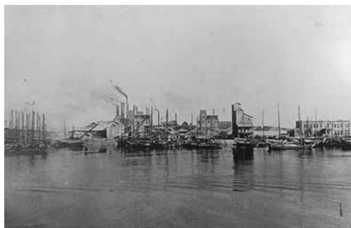
図1 日本セメント八代工場
