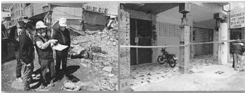
図5 技師による調査の状況および赤紙を張った建物の様子 34)
