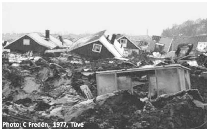
写真 1：ツーベ地すべり被害状況
