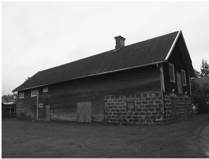
図4 グランガルデの鑄造鋳滓煉瓦造建造物
