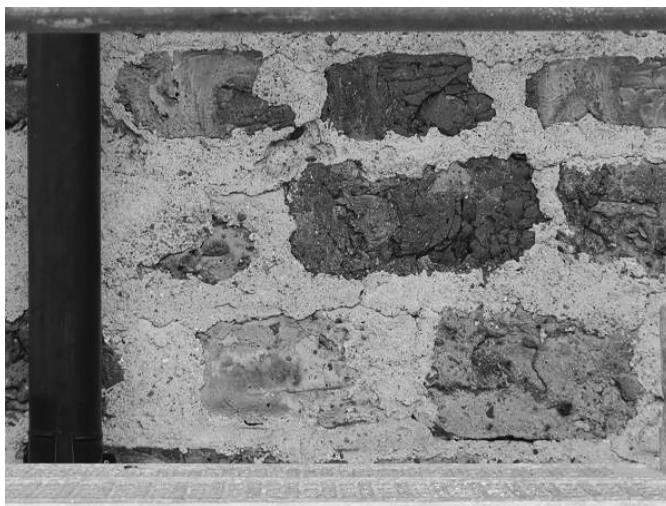
図 11 エンゲルスベリ製鉄所の鑄造鉍滓煉瓦目地補修
