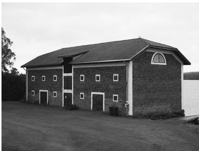
図3 スラグチップを使用した建物（グランガルデ）
