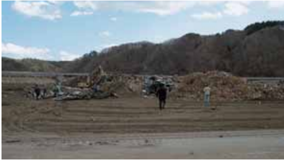
写真3 がれき堆積場と防潮堤(宮古市田老地区)
