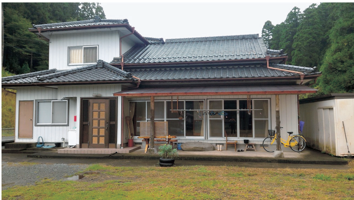
空き家を活用した広い庭のあるグループホーム（小国町）
